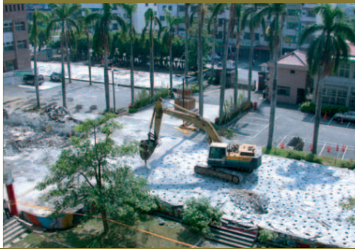
▼ 臺灣工藝文化園區整備工程進行中
