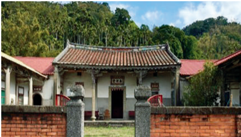
圖 2-5-1 · 歷史建築 「公館西河堂林屋下公廳」（苗栗縣政府提供）
