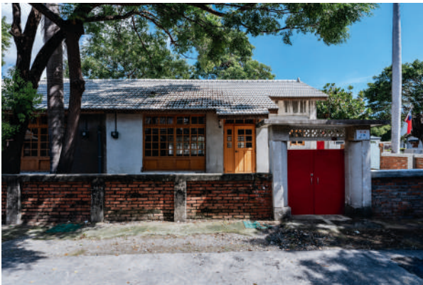
圖 2-3-38 · 鳳山黃埔新村建物整修工程（第一期）竣工照（高雄市政府提供）
