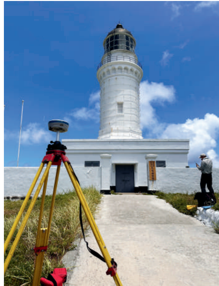
圖 5-1-2 · 國定古蹟3D掃描數位化計畫－控制測量作業－彭佳嶼燈塔
