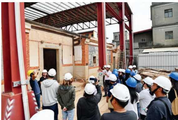
圖 3-1-4 · 2024年古蹟修復工程工地負責人培訓班—金門
