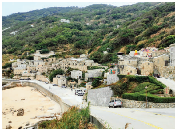
圖 3-2-5·聚落建築群－芹壁聚落建築群（連江縣政府文化處提供）
