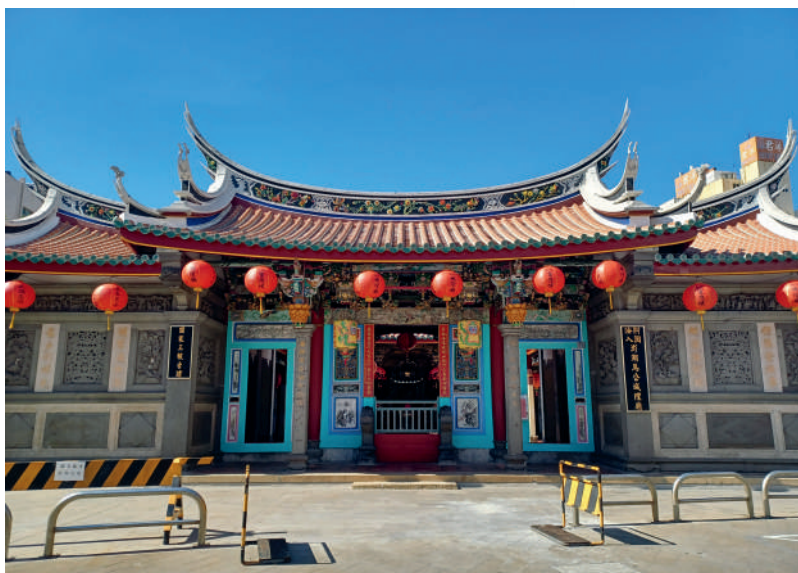
圖 2-3-9 · 媽宮城隍廟修復後正面照 (澎湖縣政府提供)
