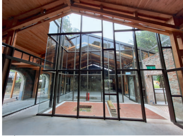
圖 2-3-35 · 虎尾眷村孝棟室內修復後現況
