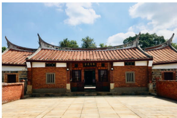
► 圖 2-5-3 · 直轄市定古蹟新屋范姜祖堂 （桃園市政府提供）
