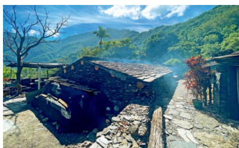
圖 3-2-3·屏東縣春日鄉老七佳石板屋聚落緊急搶修加固工程－戴家完工照片（屏東縣政府提供）
