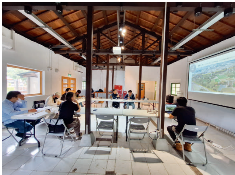
圖 2-3-14 · 虎尾眷村（活動中心）修復後室內現況
