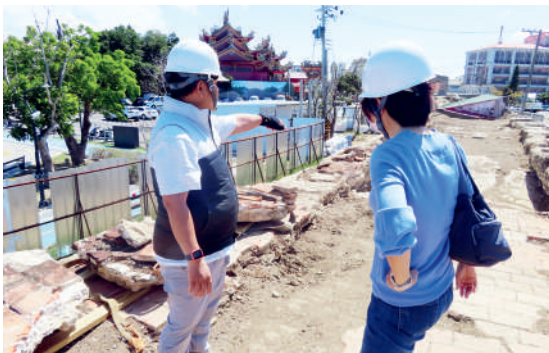
圖 3-1-24·第五分區2024年2月24日巡查人員訪談監造人員，了解恆春古城西門段工程進度
