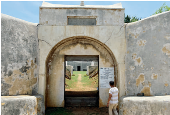
圖 3-1-26·第七分區2024年8月7日辦理國定古蹟西嶼東臺例行訪視巡查
