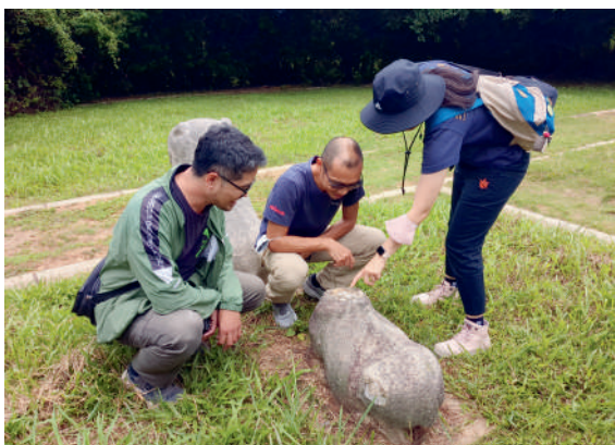
圖 3-1-18·第二分區2024年5月7日辦理國定古蹟鄭用錫墓訪視巡查—羊首斷裂3D掃描會勘
