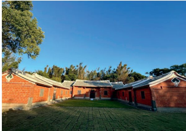
圖 2-3-2 · 簡送德古宅修復後正身正面照片 (桃園市政府提供)
