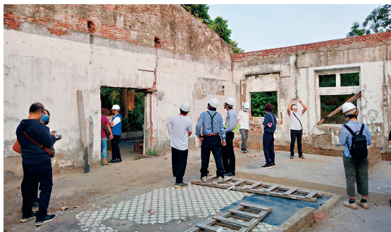
圖 2-3-26 · 雲林縣「虎尾眷村文化特區（建國一、二村）聚落歷史現場保存再現計畫」－建國一村眷舍修繕工程（忠棟）現勘
