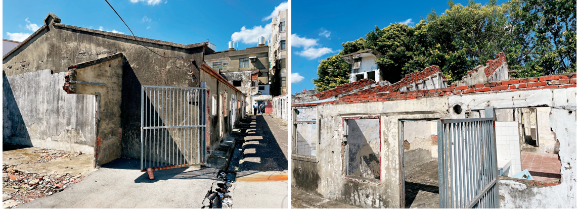
圖 2-3-16、圖 2-3-17 · 新竹縣湖口裝甲新村現況
