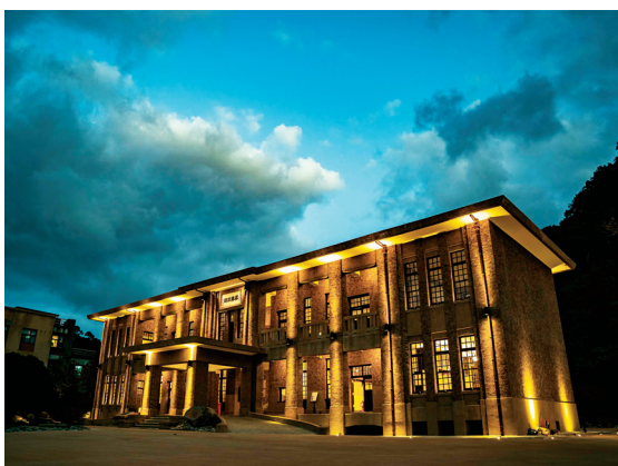
圖 2-3-1 · 市定古蹟基隆要塞司令部修復工程修復後搭配夜間燈光呈現不同風貌（基隆市政府提供）
