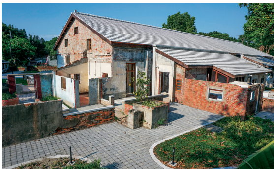
圖 2-3-34·「虎尾眷村聚落建築群（建國一村）眷舍修繕及二期景觀工程（丁棟）」竣工現況（雲林縣政府提供）
