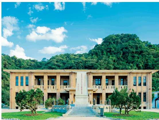
圖 2-3-7 · 市定古蹟基隆要塞司令部修復工程修復後外觀 (基隆市政府提供)
