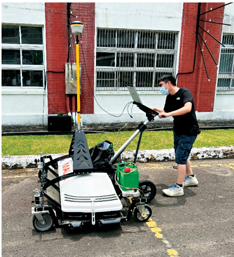
圖 5-2-13 · 臺灣當代文化實驗場現地陣列式透地雷達探測工作情形
