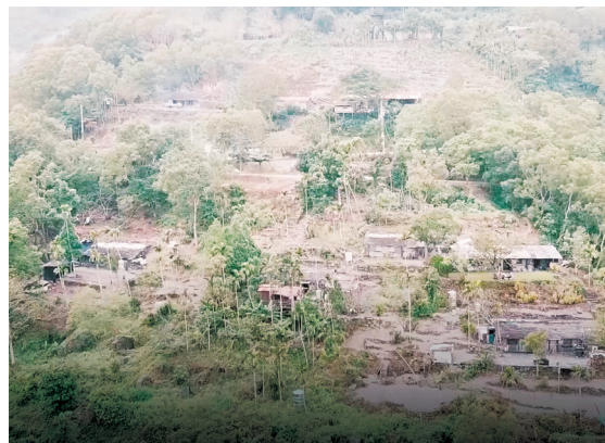
圖 2-4-2 · Kapayuwanan 舊筏灣聚落建築群 (屏東縣政府提供)
