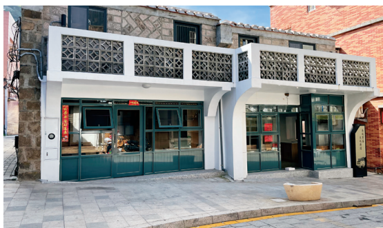
圖 2-3-28 · 「冷戰·島嶼－連江縣再造歷史現場計畫」－北竿鄉塘岐（舊街 92、94 號）再造空間修復竣工
