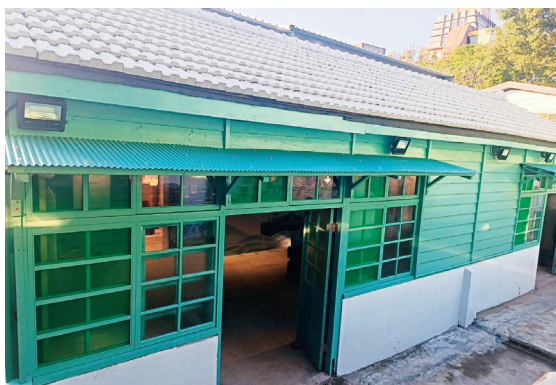
圖 2-3-20 · 臺北市「療、浴、北投—生活環境博物園區」—「北投中心新村聚落修復暨再利用第二期工程」外觀照 (臺北市政府提供)
