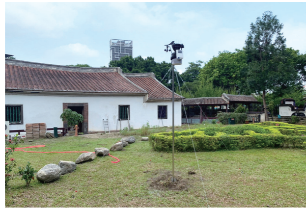
圖5-1-5 · 文化資產監測儀器設置綜合氣象站—林本源園邸
