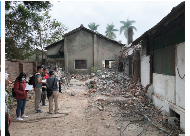
圖2-3-28 · 高雄市「三感一力眷村再生計畫」—黃埔新村現勘
