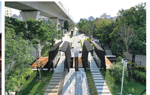
圖2-3-10 · 臺中市綠空鐵道實景
