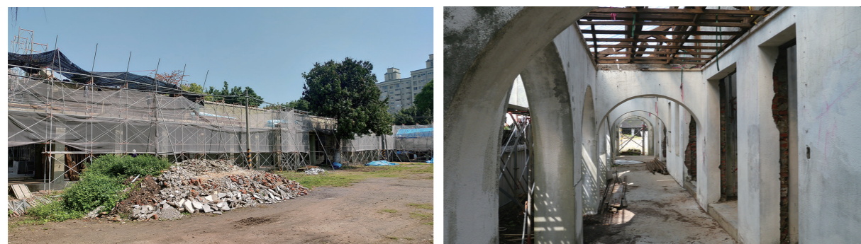
圖2-3-17 · 臺南市飛雁新村傳原通訊所外觀修復現況 | 圖2-3-18 · 臺南市飛雁新村傳原通訊所內部修復現況
