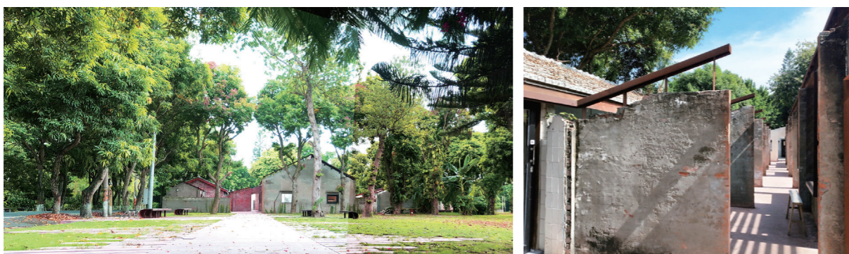
圖2-3-31 · 「虎尾眷村聚落建築群（建國一村）第一期景觀工程」已棟宿舍景觀風貌
