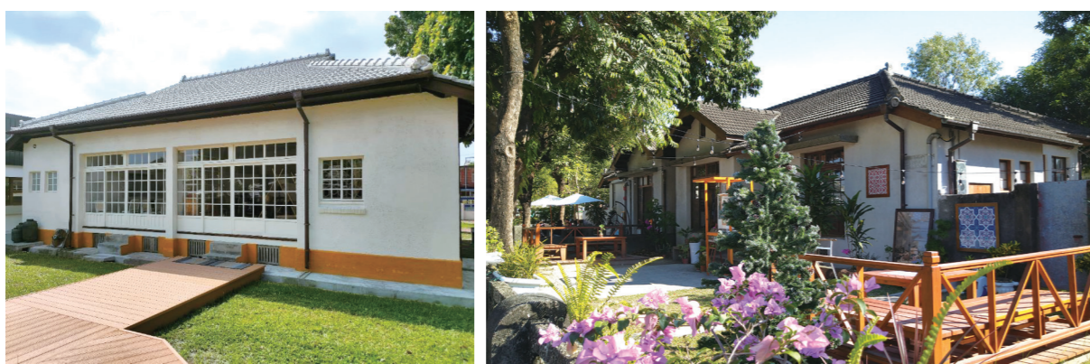
圖2-3-33 · 「屏東崇仁眷村再造歷史場域」（康定街16號）於2021年7月竣工現況
