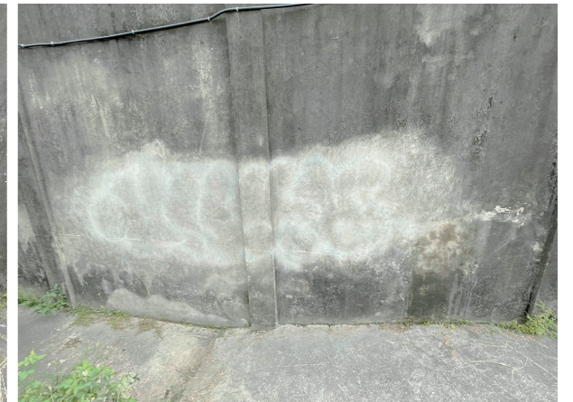
圖5-2-14 · 國定古蹟嘉義舊監獄外側圍牆塗鴉—清潔後
