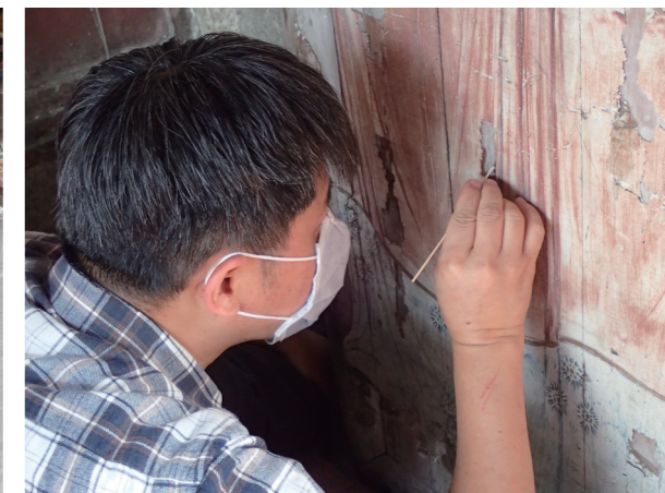
▶ 圖5-2-3 · 殘膠去除作業
