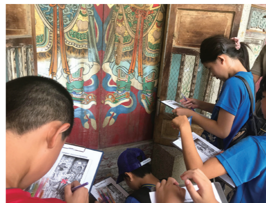
▶ 圖5-3-11 · 兒童繪本《老房子》校園教育推廣計畫，澎湖龍門國小學童進行尖山顯濟殿（舊廟）門神觀察及劣化檢視活動情形。
