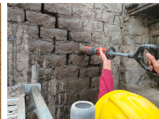
▶圖2-1-8·文化資產學院研發群組「古蹟、歷史建築土塊牆修復泥土材料施工說明書研擬」計畫研究土塊牆修復過程
