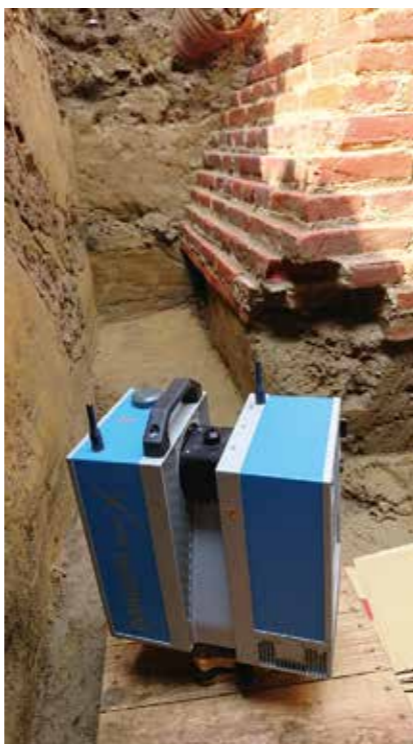
圖5-2-8 · 普羅民遮城城牆基礎轉角建築結構3D掃描
