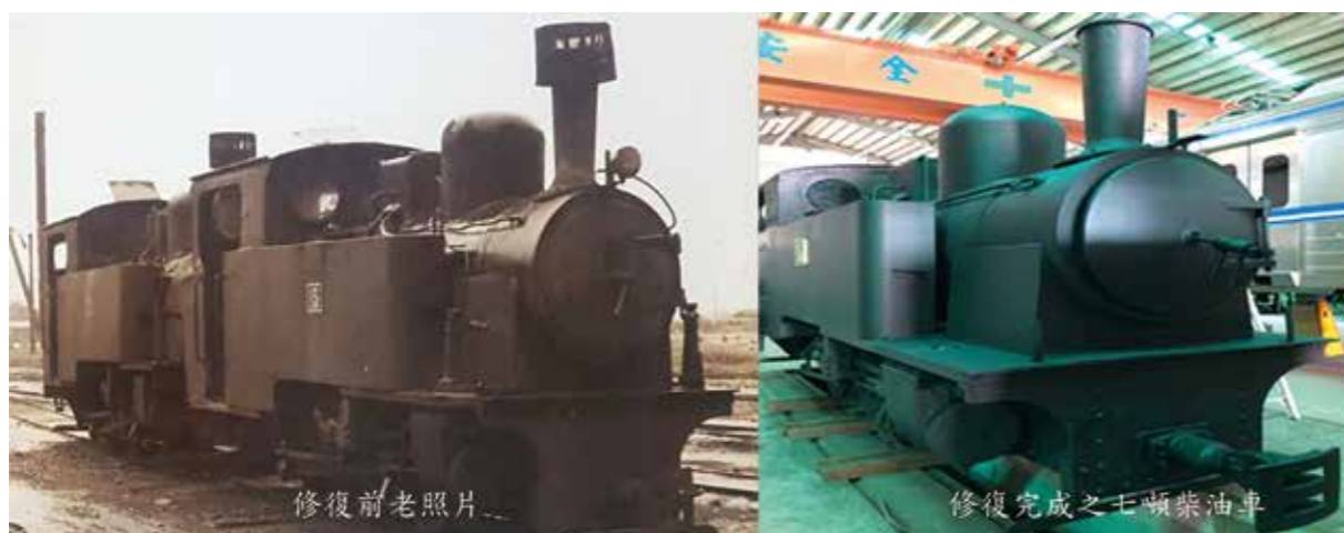
圖2-3-21 · 羅東林場七噸柴油車修復前後樣貌
