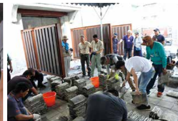
圖4-3-8 日本匠師指導臺灣學員進行舊瓦鑑別及舊瓦回鋪
