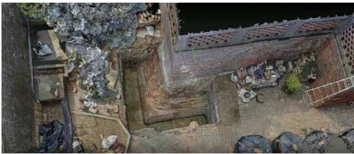
圖5-2-9 · 普羅民遮城城牆基礎轉角建築結構3D掃描結果
