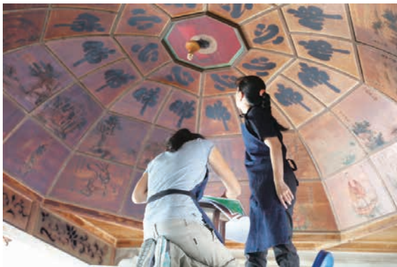
圖 5-2-5 | 藻井彩繪破損圖繪製
