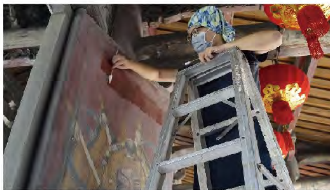
【圖5-2-5】手持棉花棒沾去離子水以濕式清潔去除門神表面污垢
