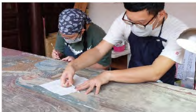
【圖5-2-6】針對五門門神裂縫使用圭筆或針筒注射黏著劑以達到加固之目的
