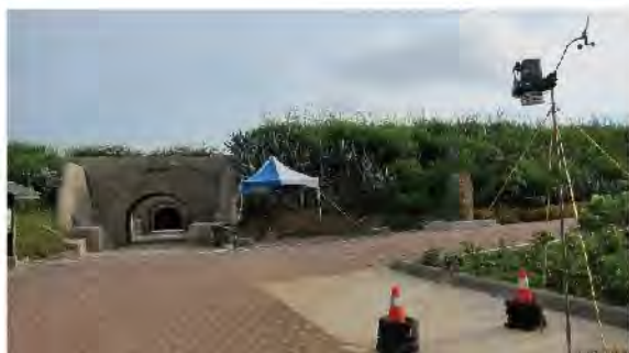
【圖5-1-2】文化資產監測儀器設置綜合氣象站—澎湖西嶼西臺
