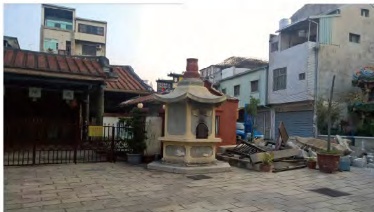
【圖3-1-3】臺南直轄市定古蹟風神廟災損情況
