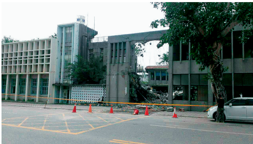
臺東縣舊稅捐處（洞洞館）拆除（臺東縣政府文化處提供）
