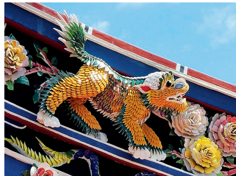
屏東縣縣定古蹟宗聖公祠前廳屋脊裝飾修復後 (保留局部舊有構件)
