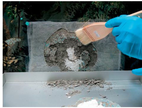
壁畫內部嚴重粉化之處理
