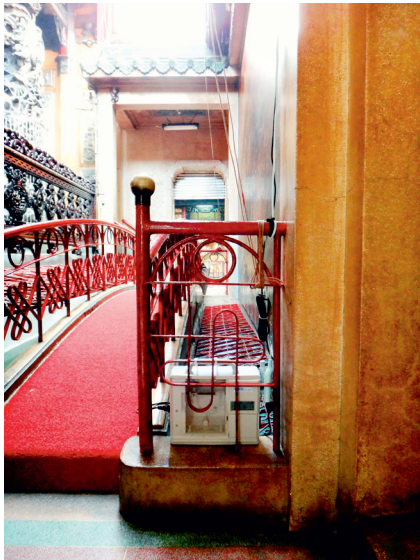
以溫濕度紀錄器進行古蹟壁體環境監測
