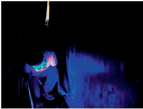
運用紫外線檢視壁畫是否有修復痕跡與其他損壞現象
