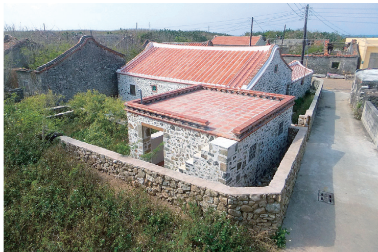
完成修復的花宅 111 號古厝背面 (劉可強提供)
