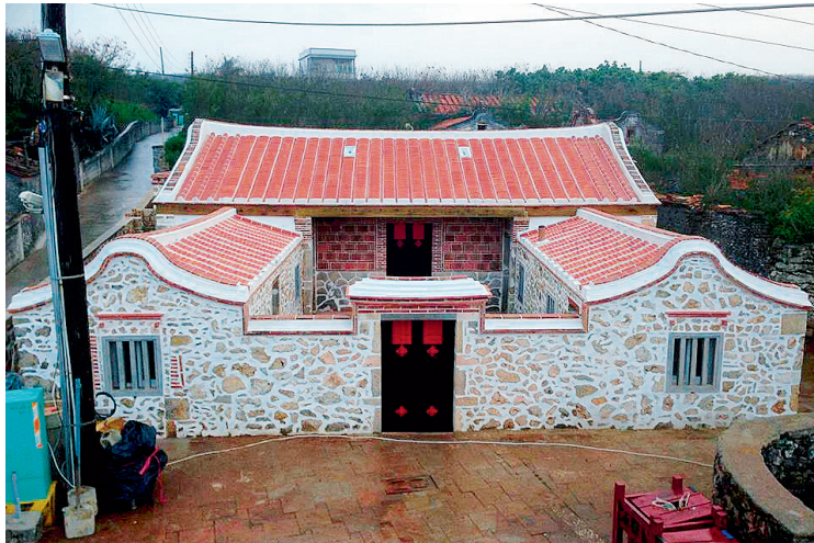
完成修復的花宅 111 號古厝，正面為壁頂巾堵白灰粉飾無裝飾彩繪 (劉可強提供)
