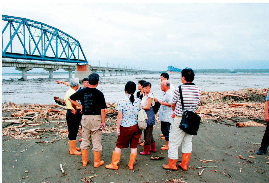
88 水災會勘現場
