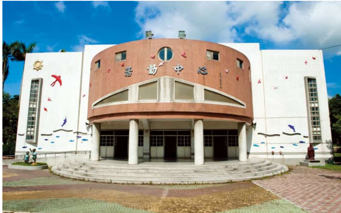
彰化縣和美鎮和東國民小學98年度老舊教室拆除重建暨附屬工程公共藝術設置案 HoDong Elementary School, Changhua County
